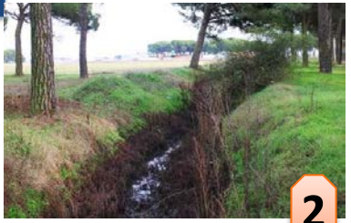
Canal de escorrentía procedente de Pedrajas
