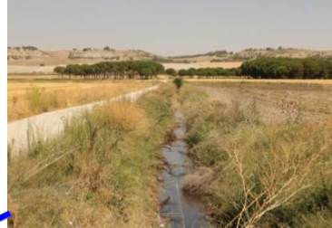
Canal de Infiltración n°2
